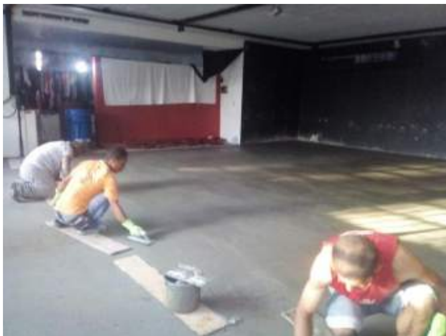
Contrapiso de nivelamento e acabamento em cimento queimado
