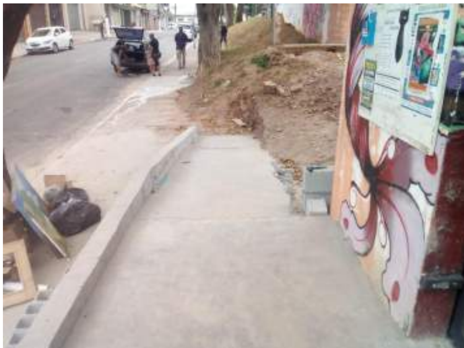
Construção de rampa de acesso
