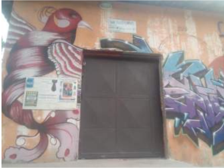
Substituição da porta de entrada (por motivos de segurança e ampliação da passagem)
