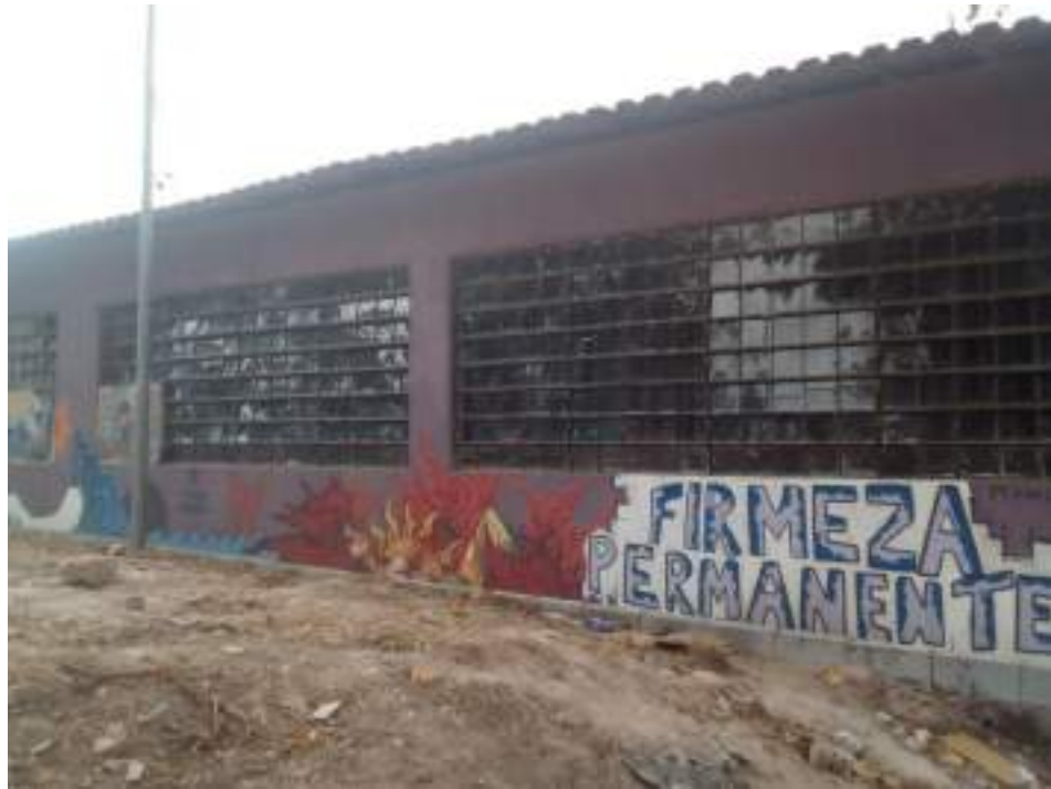
Vidros substituídos em 24.09.2017
